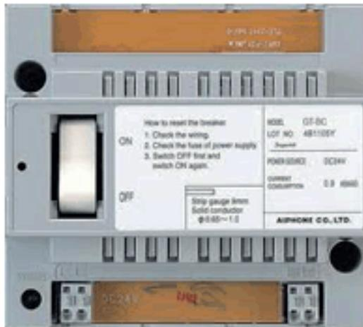
La unidad de control GT-BC Audio Bus de Aiphone se utiliza con el sistema de seguridad de entrada Multi-Tenant Serie GT. El sistema GT está construido con líneas troncales de vídeo que consta de un máximo de 6 troncos del sistema de control de bus de vídeo y comunicación líneas troncales que utilizan un punto de distribución de la unidad de control del bus GT-BC.
